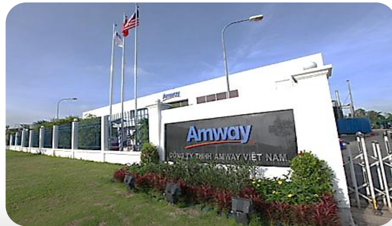
Nhà Máy AMWAY Việt Nam Khu công nghiệp Việt Nam - Singapore (VSIP) II-A, tỉnh Bình Dương
